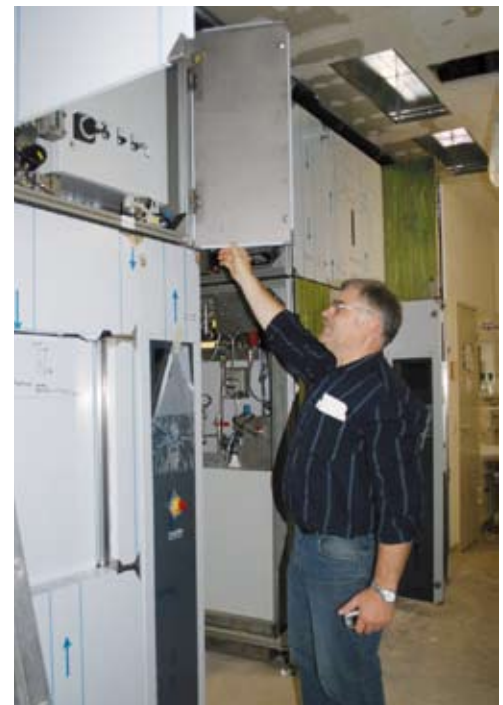
Mitte Juli standen bereits die neuen Anlagen für die Zentralsterilisation.
