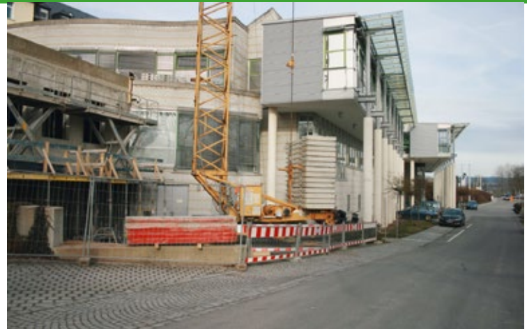
Unter laufendem Operationsbetrieb entsteht derzeit ein Erweiterungsanbau unmittelbar am bestehenden Operationsbereich.
